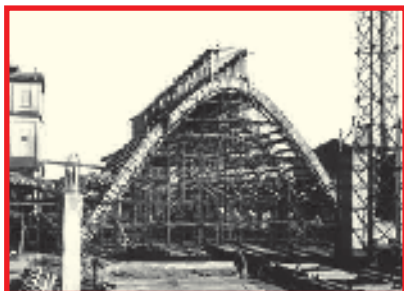
Costruzione del secondo capanno paraboloibe alla Fabbrica Cooperativa Perfosfati Cerea
